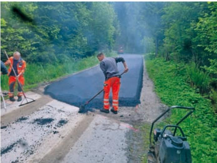
Zwei Teilstücke unterhalb der neuen Mautstelle wurden generalsaniert (Unterbau gefräst) und anschließend neu asphaltiert.
