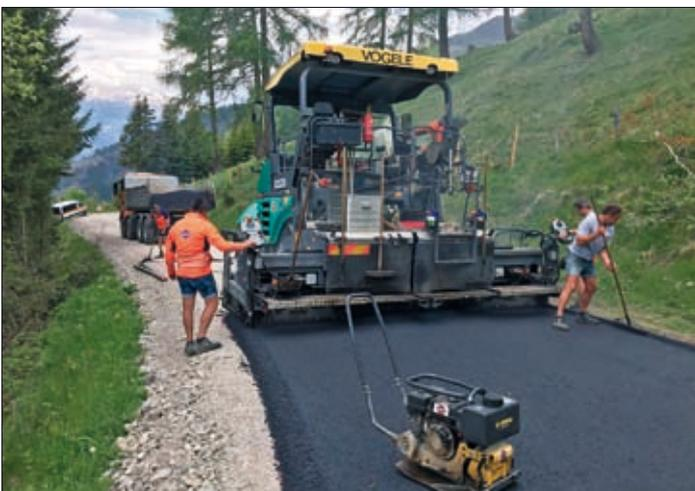
**Neuasphaltierung.** Wenn der Unterbau erneuert ist, wird die Neuasphaltierung (8 cm) durchgeführt.
