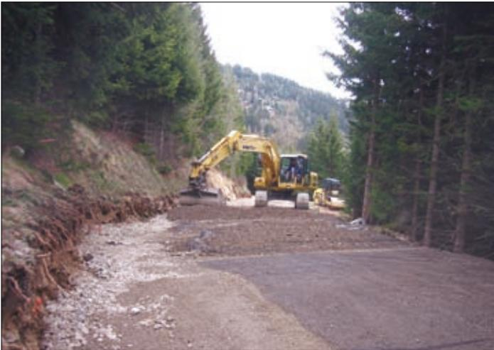
**Generalsanierungen.** Der alte Straßenkörper wird abgetragen und mit neuem zertifiziertem Frostkoffermaterial aufgebaut und entsprechend verdichtet.
