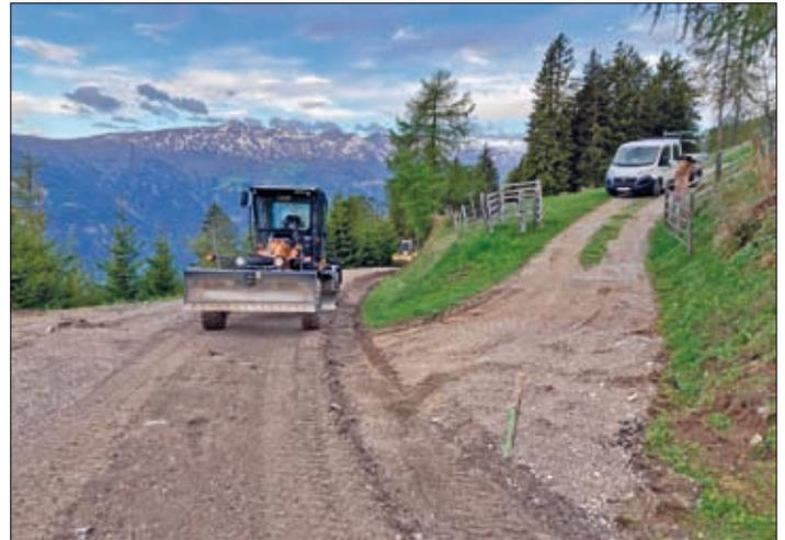
**Fräsen.** Der vorhandene Unterbau wird aufgefäst, weiter aufgeschüttet und für die Asphaltierung vorbereitet.
