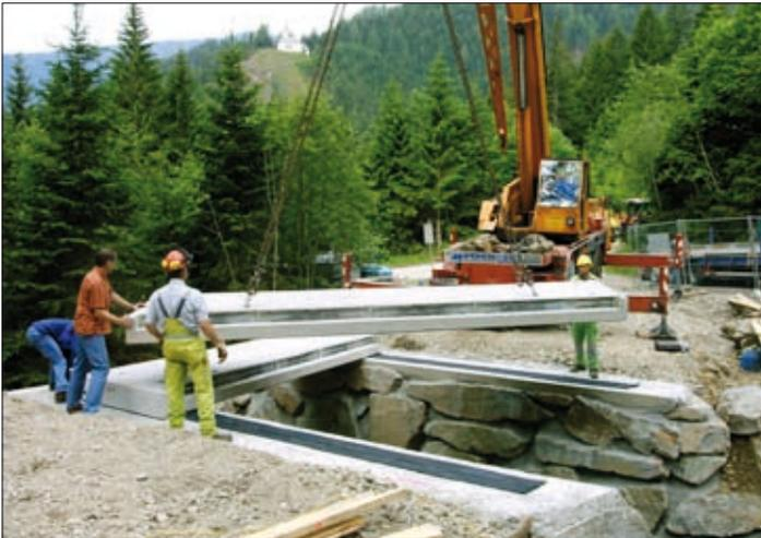
**Brückenerneuerung.** Die Thaler Brücke wird mit Fertigteil-elementen neu errichtet und gleichzeitig verbreitert.
