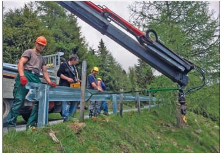
**Leitschienen.** Zur Erhöhung der Verkehrssicherheit werden bei Bedarf Stahlleitschienen errichtet.
