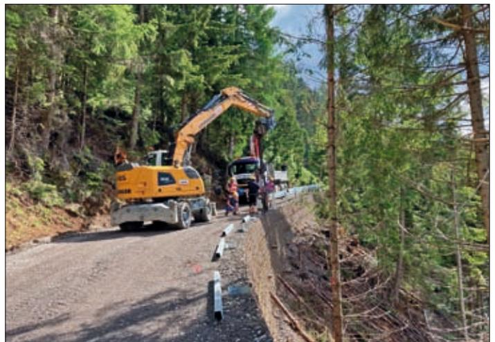
**Bewehrte Erde.** In vielen Bereichen muss bei steilem Ge-lände der Hang mit bewehrter Erde gesichert werden.
