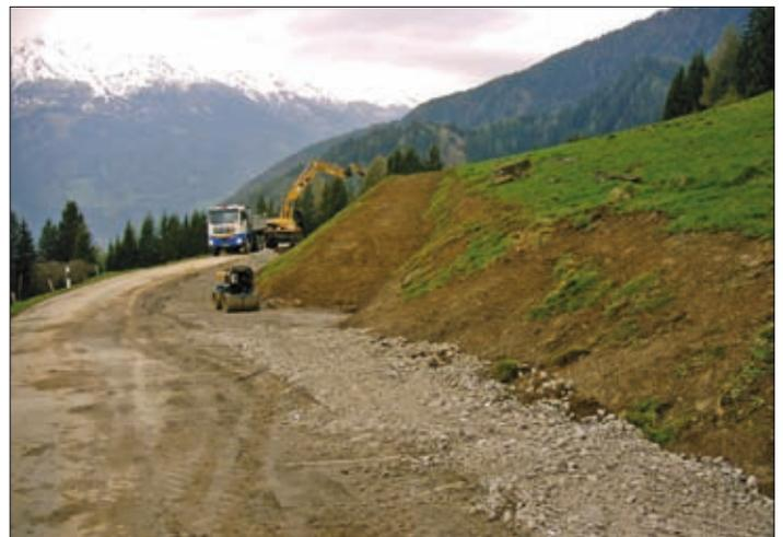
**Wegverbreiterungen.** In einigen Bereichen werden Böschungen zurückgebaut oder Felsen abgetragen.
