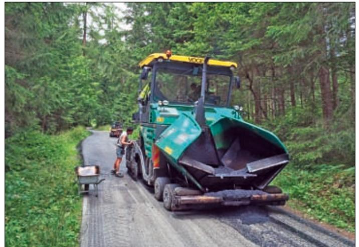
**Asphaltausbesserungen.** Auf der gesamten Weganlage werden immer wieder Asphaltanierungen durchgeführt.
