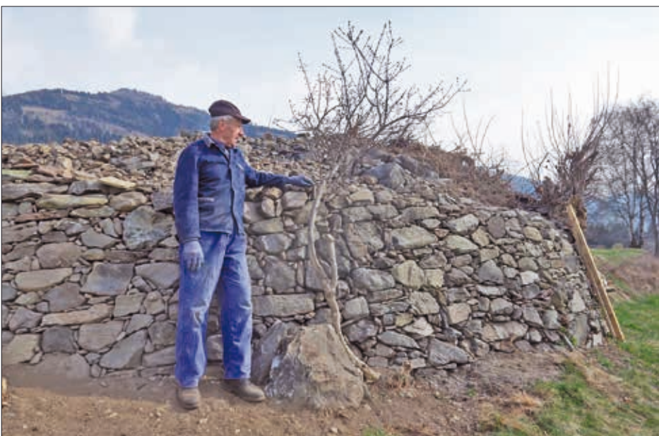
Jakob Reiter bessert mit Geduld und großer Sorgfalt die alten Trockensteinmauern aus, die den alten Fuhrweg zwischen Zauche und Riedl begleiten. Momentan mauert er im angrenzenden Feld eine zusammengefallene „Grefel“-Begrenzung wieder auf. Auf dass sie weitere hundert Jahre Bestand hat.
