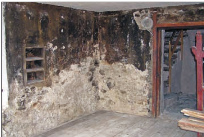
Die Stube vor der Renovierung.
