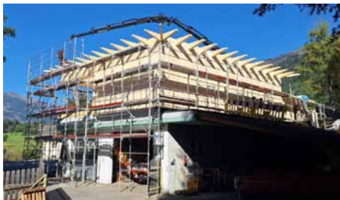
Zimmermeisterarbeiten im September 2025.
