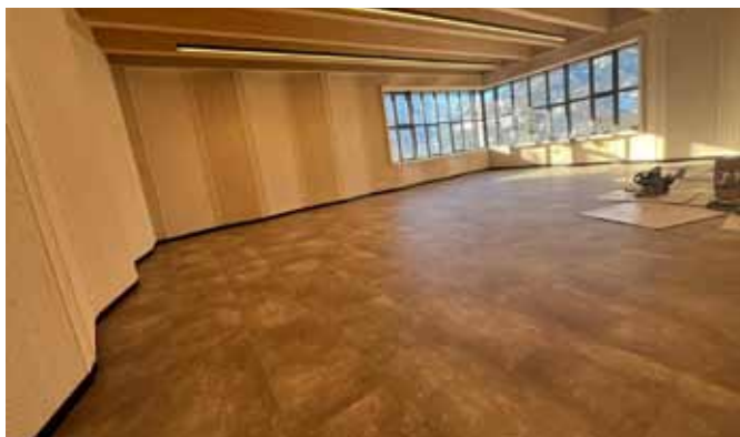
Bodenlegerarbeiten im Februar 2026.
