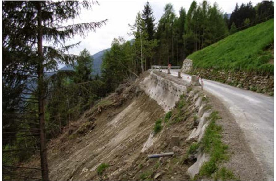
Grobsteinschichtung in Beton ersetzen. Weiters muss die Leitschiene verlängert werden. Das darunterliegende Waldgelände wird rekultiviert und wieder aufgeforstet. Die Gesamtkosten belaufen sich auf € 90.000,-.
