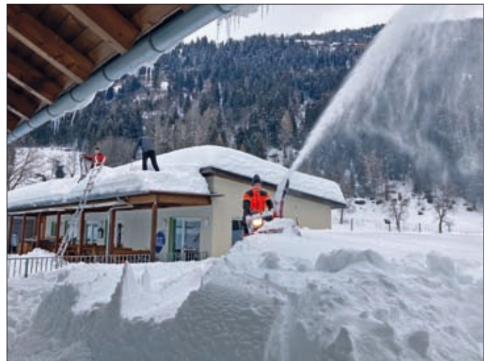
Flachere Dächer, wie z.B. von Turnsaal und Pavillon, werden mit einer Schneefräse abgefräst. Die Zentrale wird händisch abgeschöpft.
