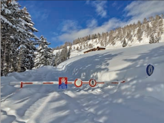
Dank der neuen Schrankenanlage am Zettersfeld konnte die Zettersfeldstraße mehrmals sicher und schnell abgesperrt werden.
