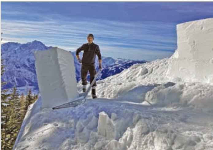
Dachabschaufeln auf einer Wochenendhütte am Zetttersfeld.
