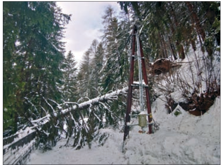
Umgestürzte Bäume auf Freileitungen behindern und erschweren die Räumarbeiten - Bild Roanaweg.
