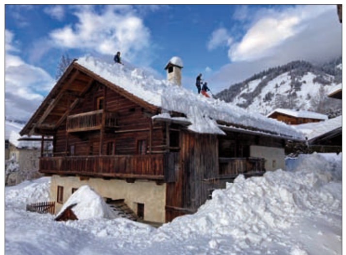
Das Kammerlander Stubenhaus. Im Innenhof sind die riesigen Schneemengen sichtbar.
