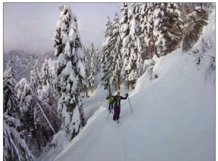
An einigen Stellen der Zetttersfeldstraße ist der Straßenverlauf aufgrund der Schneerutschungen kaum mehr zu erkennen.
