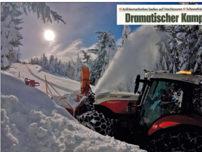
In Bereichen, wo keine Bäume über die Straße liegen, gehen die Fräsarbeiten zügig voran - Bild Zetttersfeldstraße.
