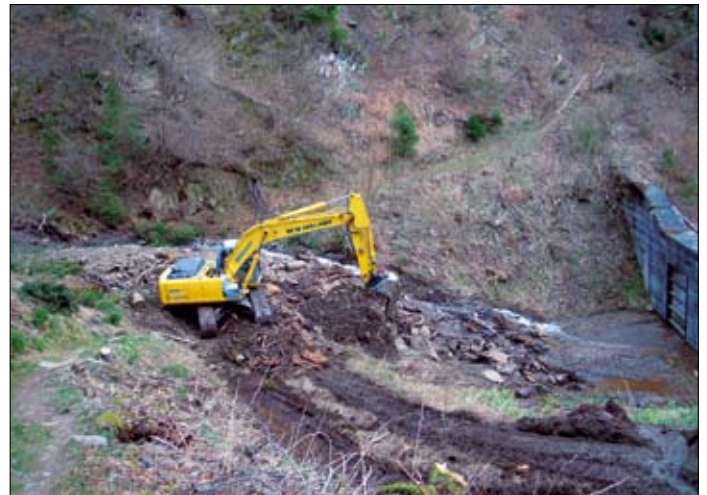
Das Auffangbecken im Großbachtal.
