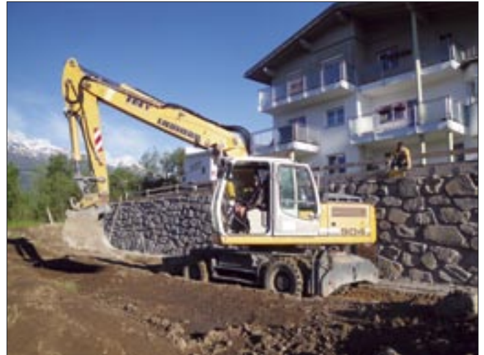
Errichtung der Stützmauer für die Zufahrt Wohnanlage Kammerlanderfeld.
