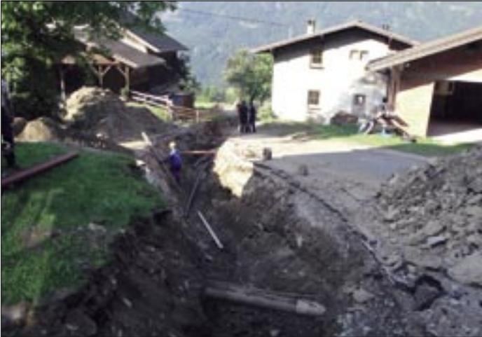
**Ende Juni.** Verlegung von Kanal und Wasserleitungen im Bereich Oberthaler - Bartler - Trattner. Zahlreiche Leitungen (Wasser, Beregnung, Tiwag, Telekom ...) müssen gequert werden.
