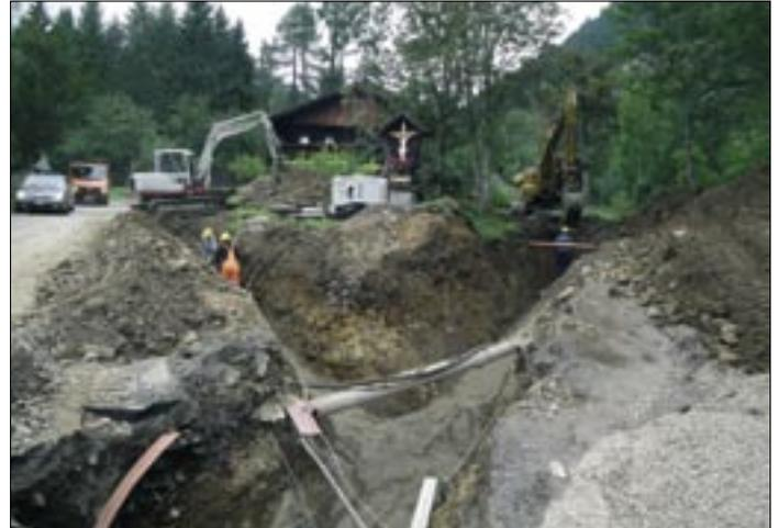
**Mitte August.** Kanalverlegung zum Soga (nach links) und Einbau von Wasserleitungen zum Hochbehälter und Quellteilungsschacht (nach rechts).
