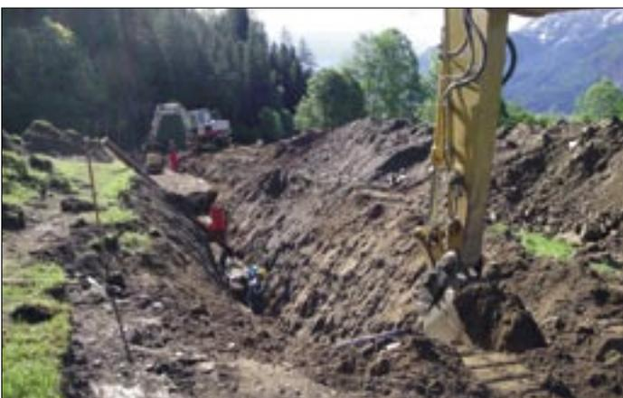
**Ende Mai.** Verlegung Kanal und Wasserleitungen im Unterthaler Feld – Leitungen müssen in 3,50 m Tiefe unter dem Zauchenbach eingebaut werden.
