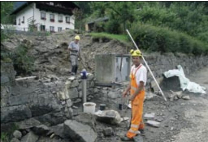
**Anfang August.** Einbau eines Löschwasserhydranten und eines Feuerwehrkastens hinterm Unterniggler. Der alte Hydrant beim Niggler Stöckl wurde entfernt.
